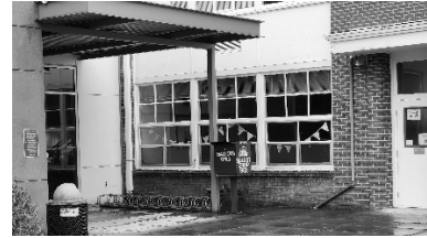
مركز Benton لكلية LBCC (LBCC المجتمعية) (Benton Center)
